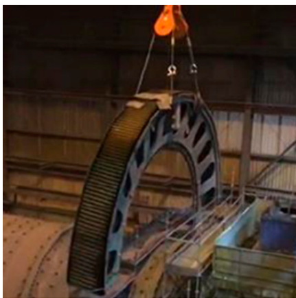
Cambio de Corona y piñón MB Minera Candelaria
